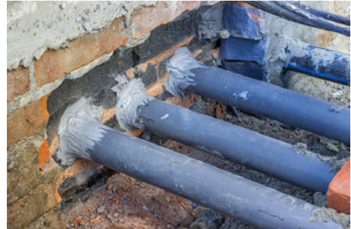
Abb. 15: Abgedichtete Rohrleitungen
